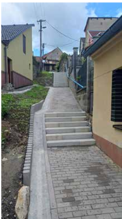
Oprava kanalizace a vodovodních přípojek Šraňky
