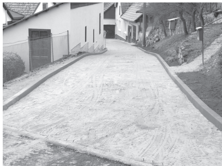
Rekonstrukce komunikace ul. Zádvoří
