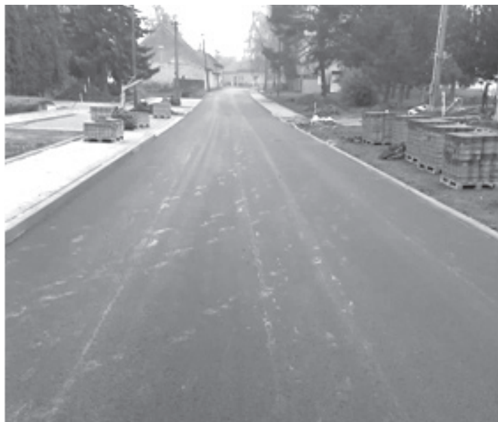
Rekonstrukce ul. Mládežnická
